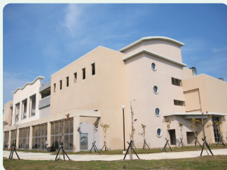
▼ 台電澎湖一次變電所
