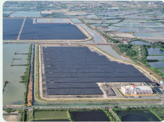
▼ 台電台南鹽田150MW太陽光電
