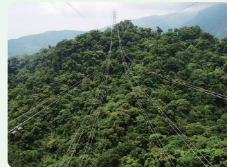
▼ 台電玉里~豐濱輸電線路工程
